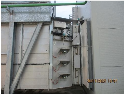
ภาพที่ 2.2-26 ระบบป้องกันการรั่วซึมของก๊าซ (Gas Detector บริเวณ Gas Turbine)
