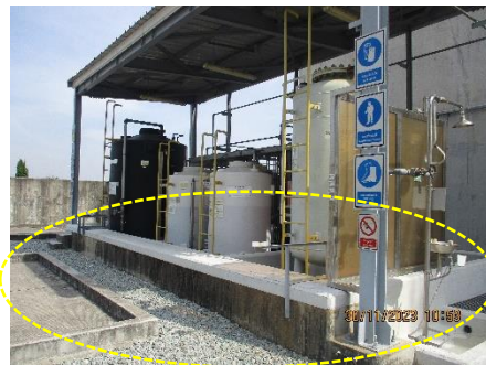
ภาพที่ 2.2-33 คันคอนกรีตรอบถังเก็บ
