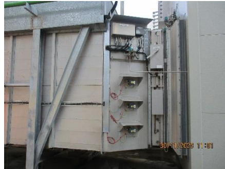
ภาพที่ 2.2-26 ระบบป้องกันการรั่วซึมของก๊าซ (Gas Detector บริเวณ Gas Turbine)
